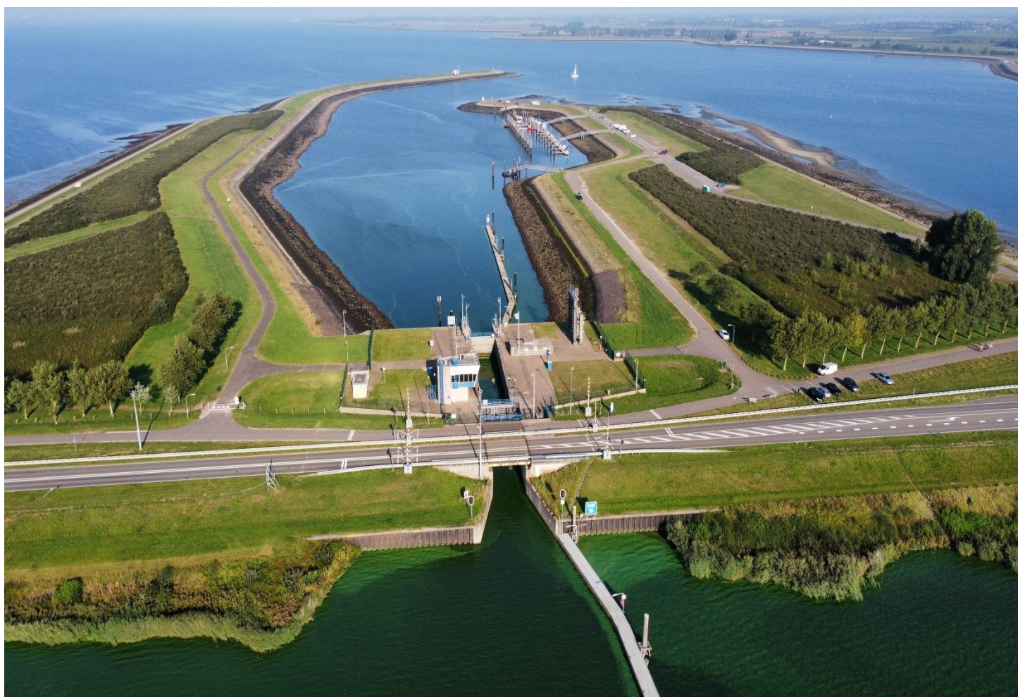
Bergse Diepsluis, - Foto: Bram Aertssen
